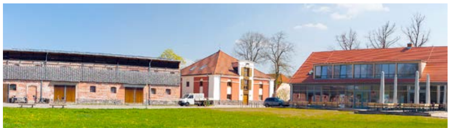
Nationalparkhaus (Besucherzentrum), Gemeindehaus und NATURA-2000-Haus
