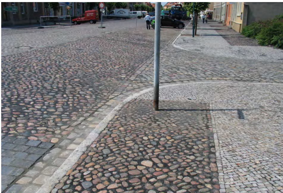
Beispiele für Barrierefreiheit durch Pflastersanierung in Konstanz (o. l.), Kalkar (o. r.) und Ziesar
