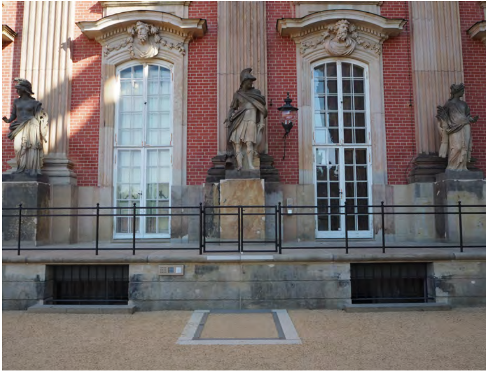
Der Lift am Neuen Palais im Ruhezustand
