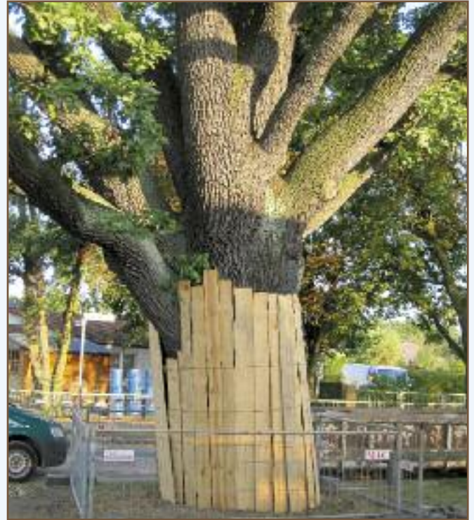
Eiche an der Saarlandstraße in Oranienburg – Baumschutz bei Bauarbeiten im September 2012 (Irmela Wübbe)
